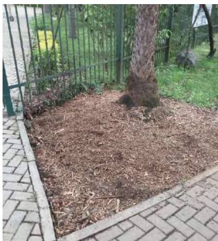
Foto 39: Requalificação de área que fica na entrada do parque (tempo 1).
