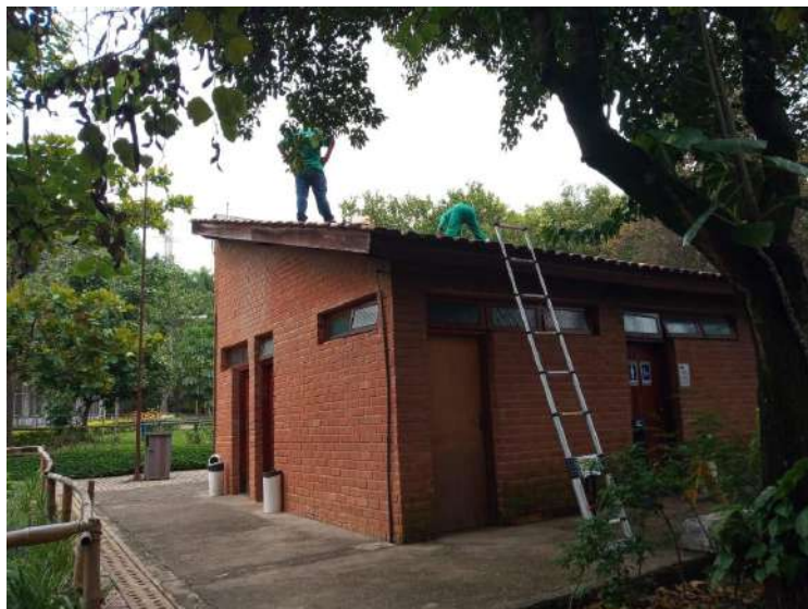
Figura 79: Limpeza caixa d'água
